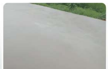
งานบำรุงถนนสาย นม. 4033 : แยกทางหลวง หมายเลข 2256 (กม.ที่43+650) บ้านช่องสำราญ
